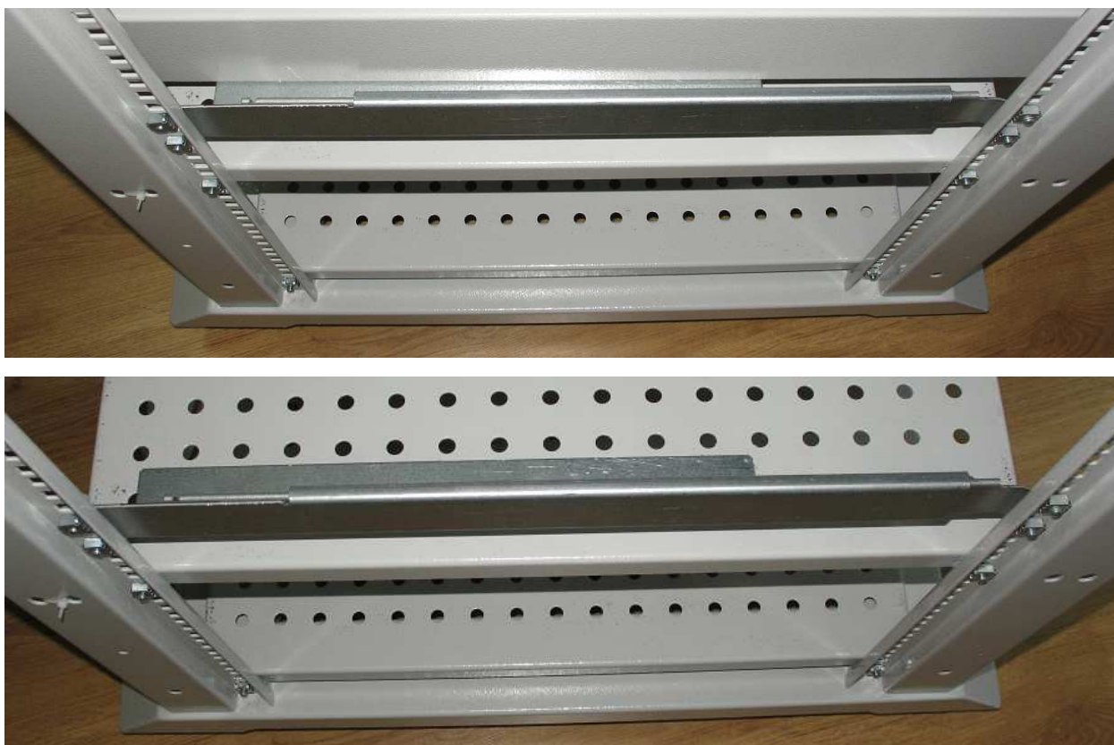
Рисунок 5 – Вид на поддерживающий уголок кронштейна с оборудованием и без
