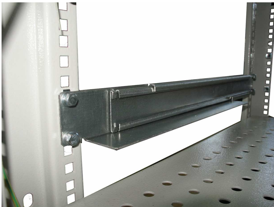
Рисунок 4 – Вид на кронштейн и поддерживающий уголок
